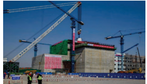
Şekil 4.15: HTR-PM nükleer santrali inşaatı [4.20]
