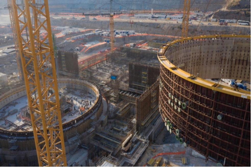
Şekil 7.1: Akkuyu Nükleer Santral inşaat faaliyetleri
