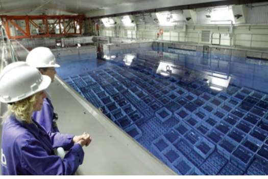
Şekil 5.3: İsveç Merkezi Geçici Depolama Tesisi (CLAB) [5.15]
