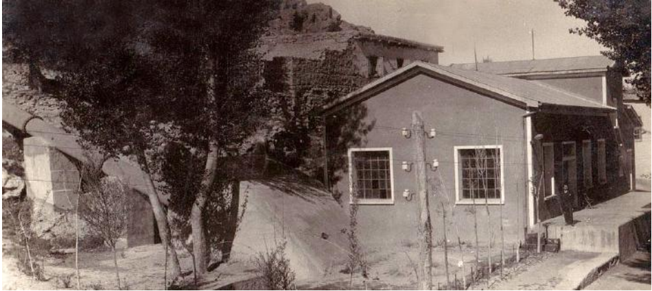
Şekil 13. Bünyan Elektrik Fabrikası (Akpınar, 2018, s.374)
