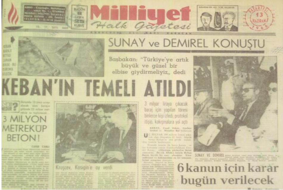
Şekil 14. Keban Barajı ve HES'in temel atma töreni ile ilgili gazete haberi
