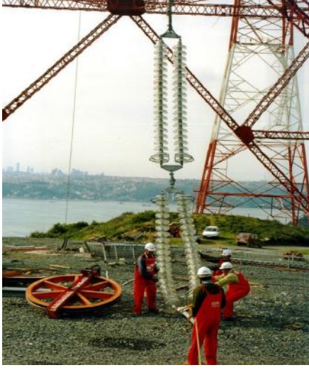
Şekil 14. Çift V aski zincir izolatör takımının montaja hazırlanması
