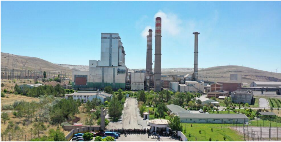
Şekil 17. Kangal Termik Santrali (Başaran 04, S1)
