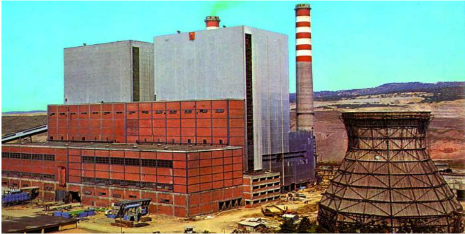
Şekil 8. Tunçbilek Termik Santrali ( www.enka.com )
