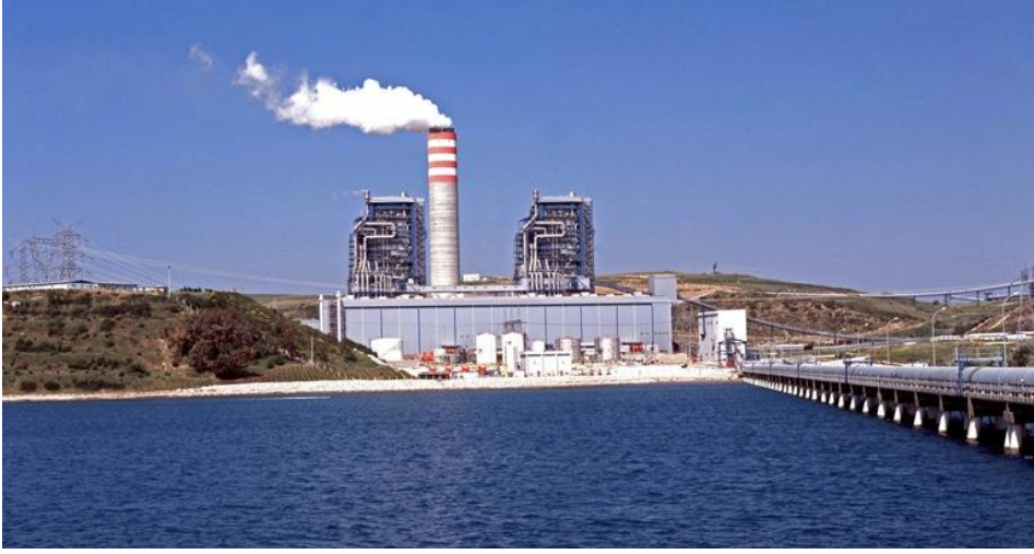
Şekil 23. Isken Sugözü Termik Santrali ( www.isken.com.tr )
