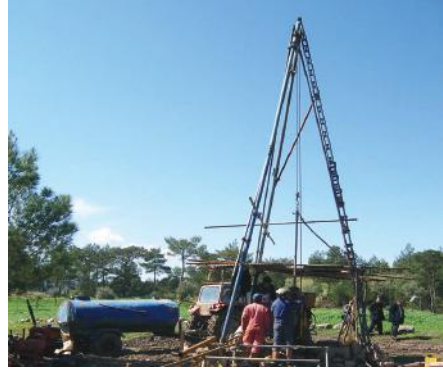
Şekil 4. Zemin Etüt Çalışmaları
