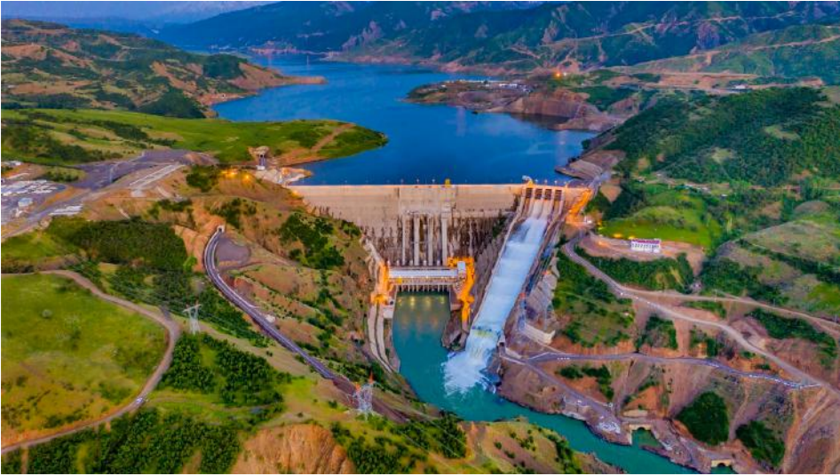
Şekil 24. Yukarı Kaleköy Barajı ve Hidroelektrik Santrali
