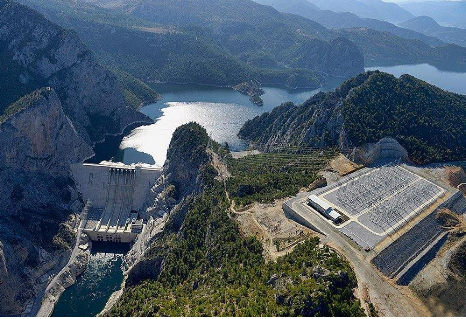
Şekil 26. Boyabat Barajı ve Hidroelektrik Santrali
