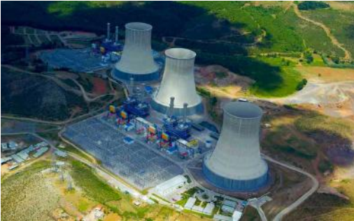
Şekil 12. Enka Gebze ve Adapazarı Doğal Gaz Santralleri (Enka web sitesi)
