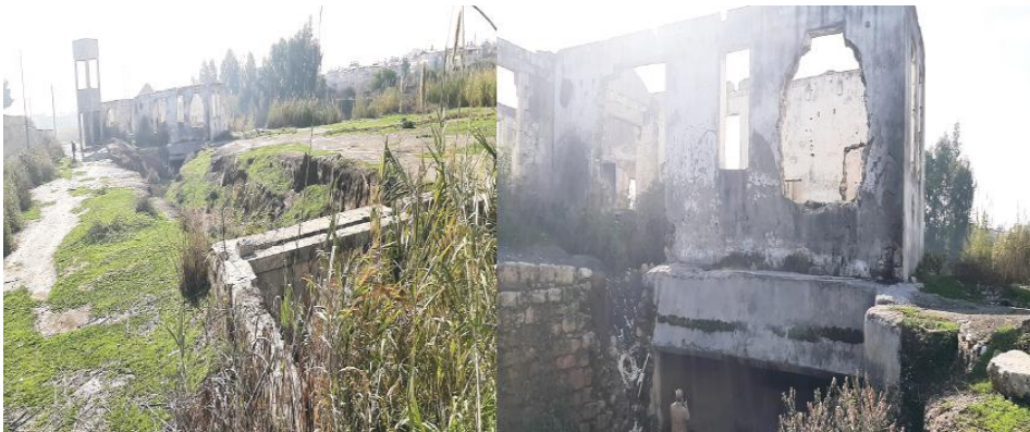
Şekil 1. Tarsus Hidroelektrik Santral Binası görünümü- Ocak 2022
