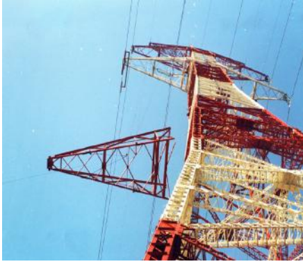
Şekil 15. Taşıyıcı atlama direğinde konsol montajı
