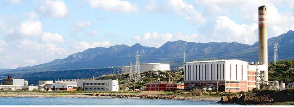
Şekil 1. Tekneçik Fuel Oil Santrali (2 x 60 MW)
