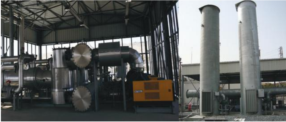
Şekil 6. Blower ve Flare Üniteleri
