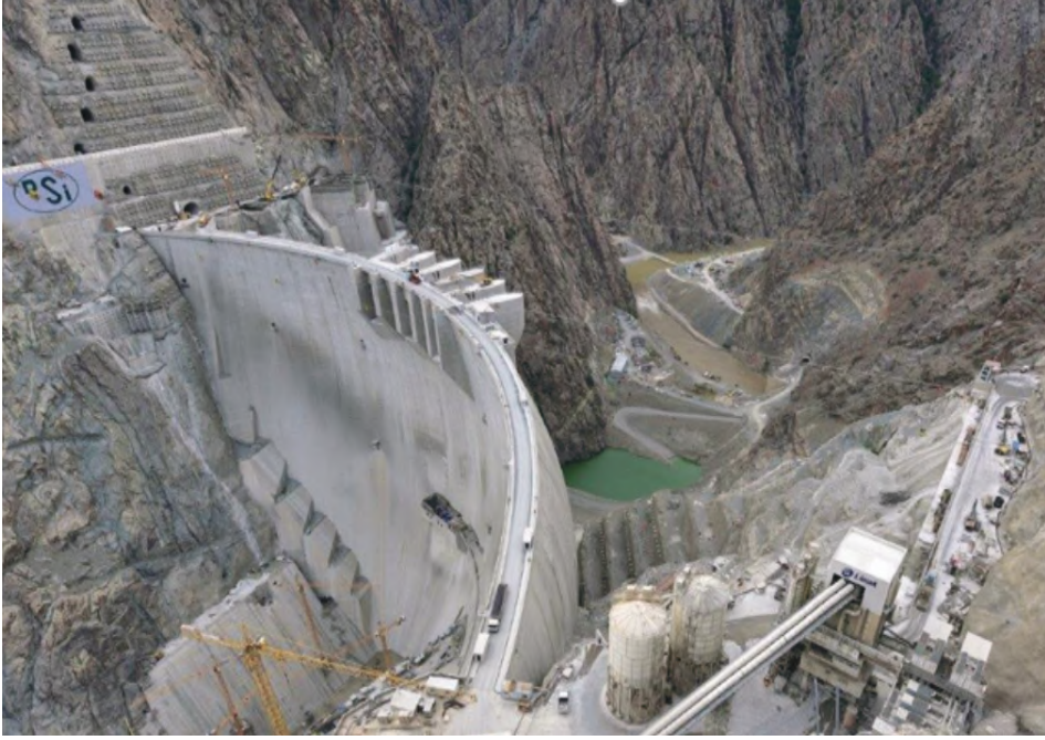
Şekil 21. Yusufeli Barajı İnşaatı
