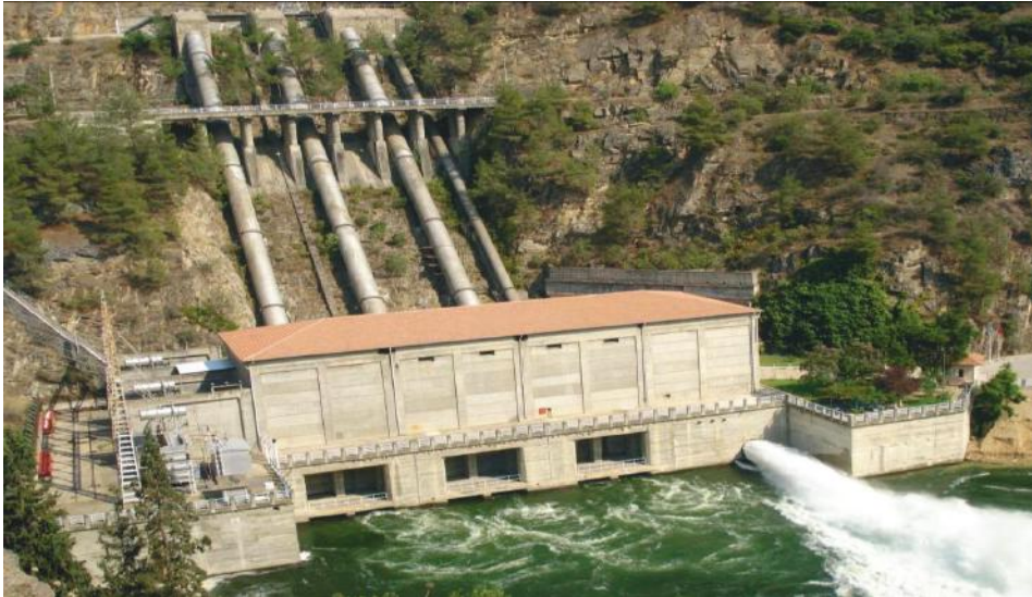
Şekil 7. Demirköprü Hidroelektrik Santrali
