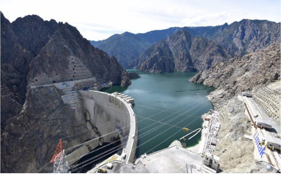
Şekil 8. Yusufeli Barajı ve HES.
