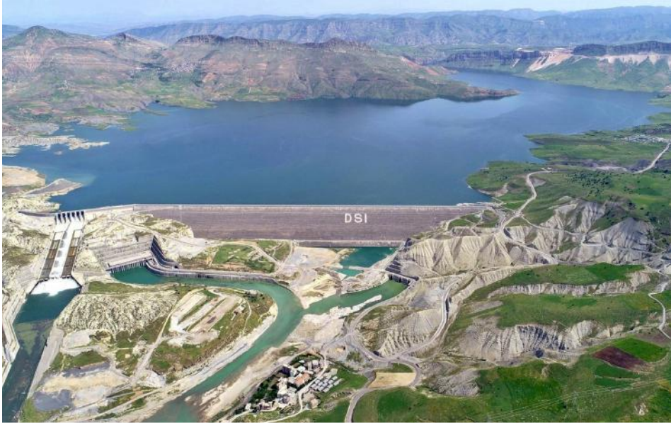
Şekil 20. Ilısu Barajı ve Hidroelektrik Santrali
