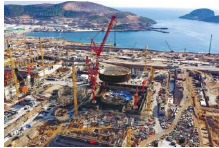
Şekil 14. Akkuyu NGS Sahası İnşaat Faaliyetleri (Akkuyu AŞ; foto galeri)
