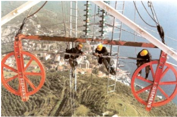
Şekil 10. Tel çekim çalışmaları (iletkenin makaralardan klempe aktarılması)
