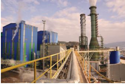
Şekil 3: Samsun Aksa Mobil Santrali (www.aksaenerji.com.tr)
