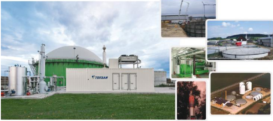
Şekil 1. Eskişehir-TİGEM Biyogaz Tesisi'nde bulunan 250 kW kapasiteli Kojenerasyon sistemi
