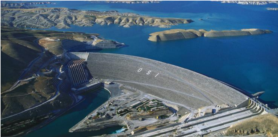
Şekil 19. Atatürk Barajı ve Hidroelektrik Santrali
