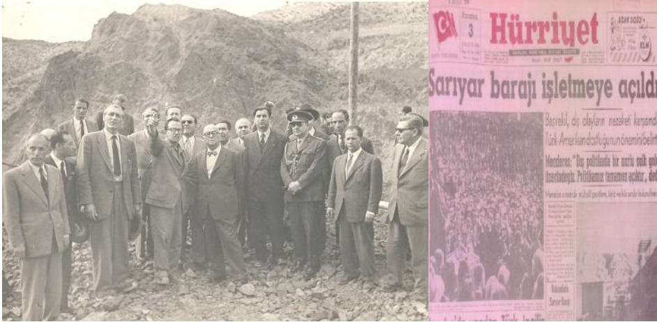
Şekil 6. Dönemin Cumhurbaşkanı Celal Bayar'ın Sarıyar baraj-santral inşaatını ziyaretinde çekilen fotoğraf ve Hürriyet Gazetesi'nin 3 Aralık 1956 tarihli Sarıyar Barajı ve HES'in açılışı ile ilgili haberi.
