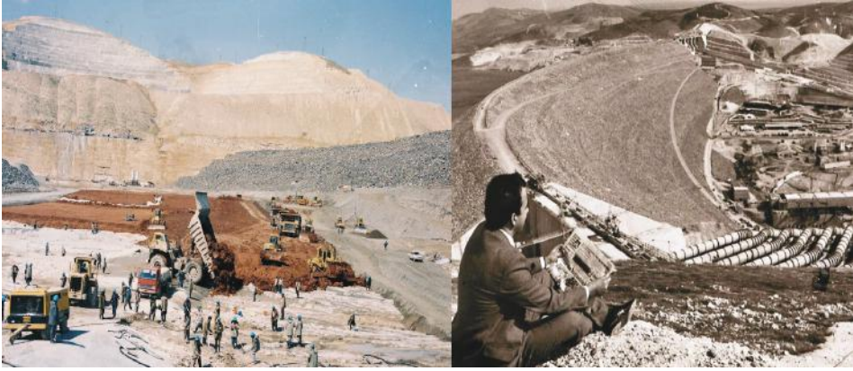
Şekil 18. Atatürk Barajı İnşaatı Aşamaları-Gövde Taban Temizliği Kil Dolgusu
