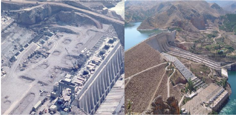
Şekil 15. Keban Hidroelektrik Santral Binası İnşaatı ve Keban Barajı ve Hidroelektrik Santrali
