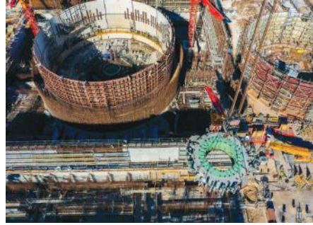
Şekil 12. Akkuyu NGS Sahası İnşaat Faaliyetleri (Akkuyu AŞ; foto galeri)
