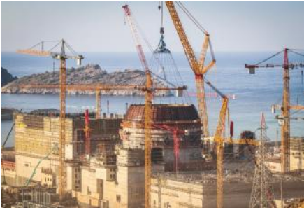
Şekil 13. Akkuyu NGS Sahası İnşaat Faaliyetleri (Akkuyu AŞ, foto galeri)
