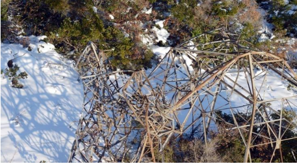
Şekil 7. 400 kV Adapazarı-Tepeören Kuzey EİH 3685 No.lu direk (29 Aralık 2016)
