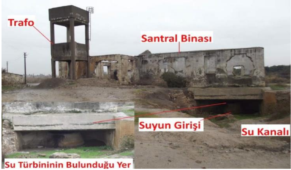
Şekil 7. Tarsus Elektrik Santral Binasının Kuzey Cephesinden Görünümü (O. Arslan, 2017, s.8)
