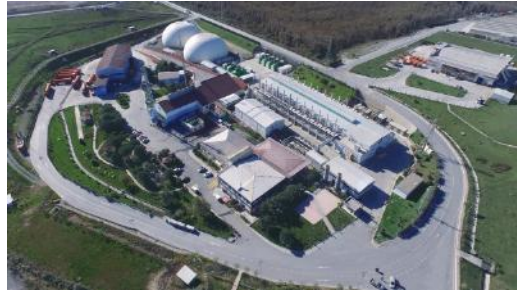
Şekil 4. Odayeri Çöp Biyogaz Elektrik Üretim Tesisi
