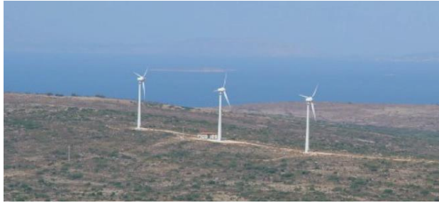
Şekil 6. Türkiye'deki İlk Rüzgâr Santrali Germiyan RES (Kaynak: Demirer Holding Web Sitesi)
