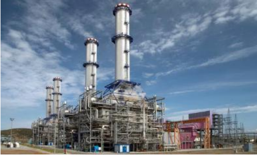
Şekil 11. Enka İzmir Doğal Gaz Kombine Çevrim Santrali (Enka web sitesi)
