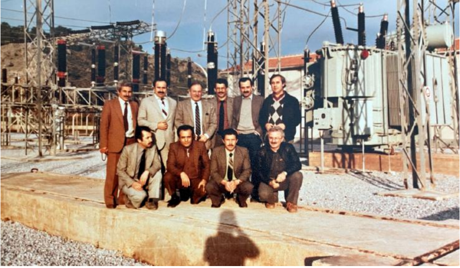
Şekil 2. Marmaris Trafo Merkezi, 1984
