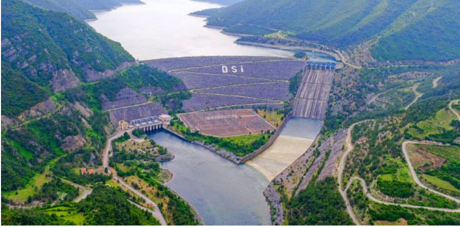
Şekil 10. Altınkaya Barajı ve Hidroelektrik Santrali
