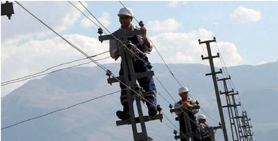
Şekil 1. Köy Elektrifikasyon çalışmaları
