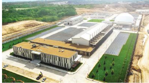
Şekil 5. Seymen-Silivri Çöp Biyogaz Elektrik Üretim Tesisi
