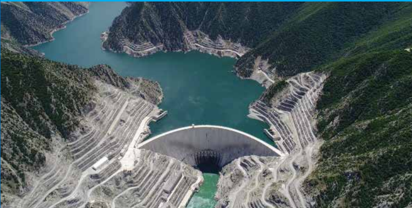
Şekil 2: Deriner Hidroelektrik Santrali
