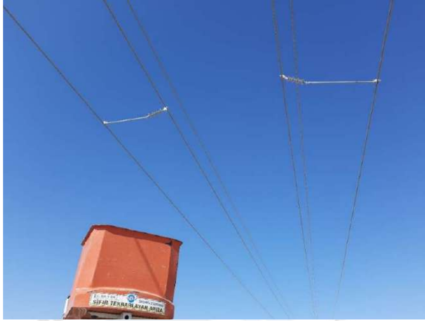
Şekil 17. Konya ili Selçuklu-2 DM-79 Tömek Eğribayat DM A ve B Barası Fazlar Arası Aralayıcı Pilot Uygulaması
