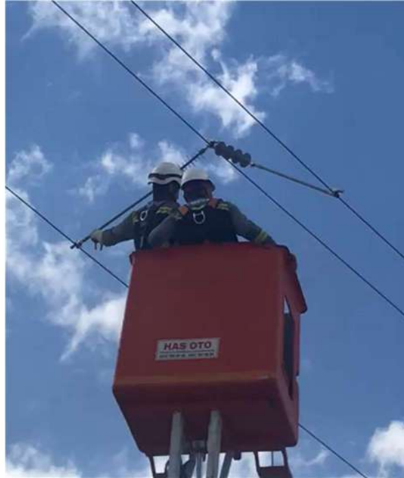
Şekil 18. Niğde ili Mislioiva TM F-3 Alay Fideri fazlar arası aralayıcı pilot uygulaması
